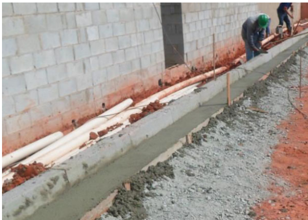
FIGURA 2: Exemplo de execução de sarjeta moldada in-loco
