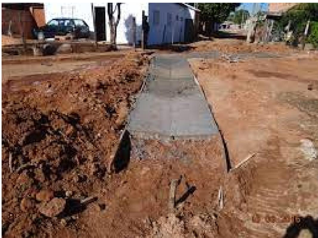
FIGURA 6: Exemplo de execução de sarjetão
