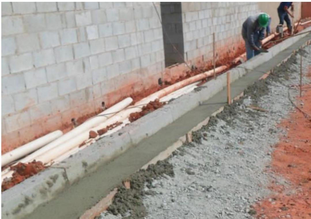
FIGURA 5: Exemplo de execução de sarjeta moldada in-loco
