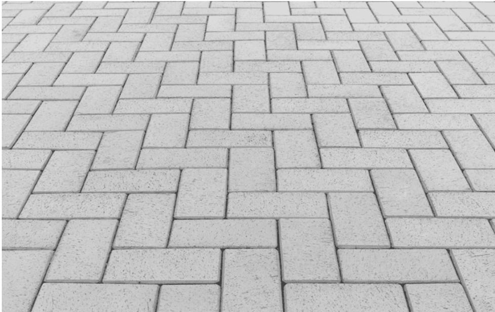
FIGURA 8: Tipo de encaixe “espinha-de-peixe” a ser adotada na pavimentação da Rua “A”
