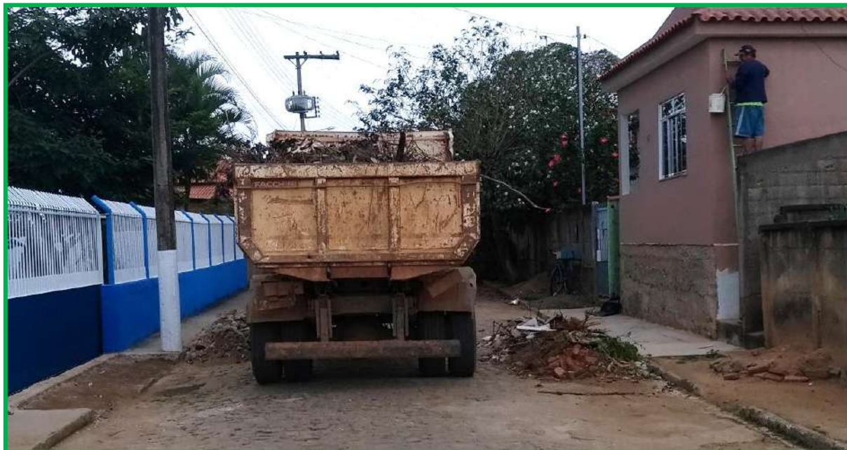
Figura 55 – Coleta de resíduos provenientes de construção civil. Fonte: Ideal Consultoria Ambiental e Urbanística LTDA
